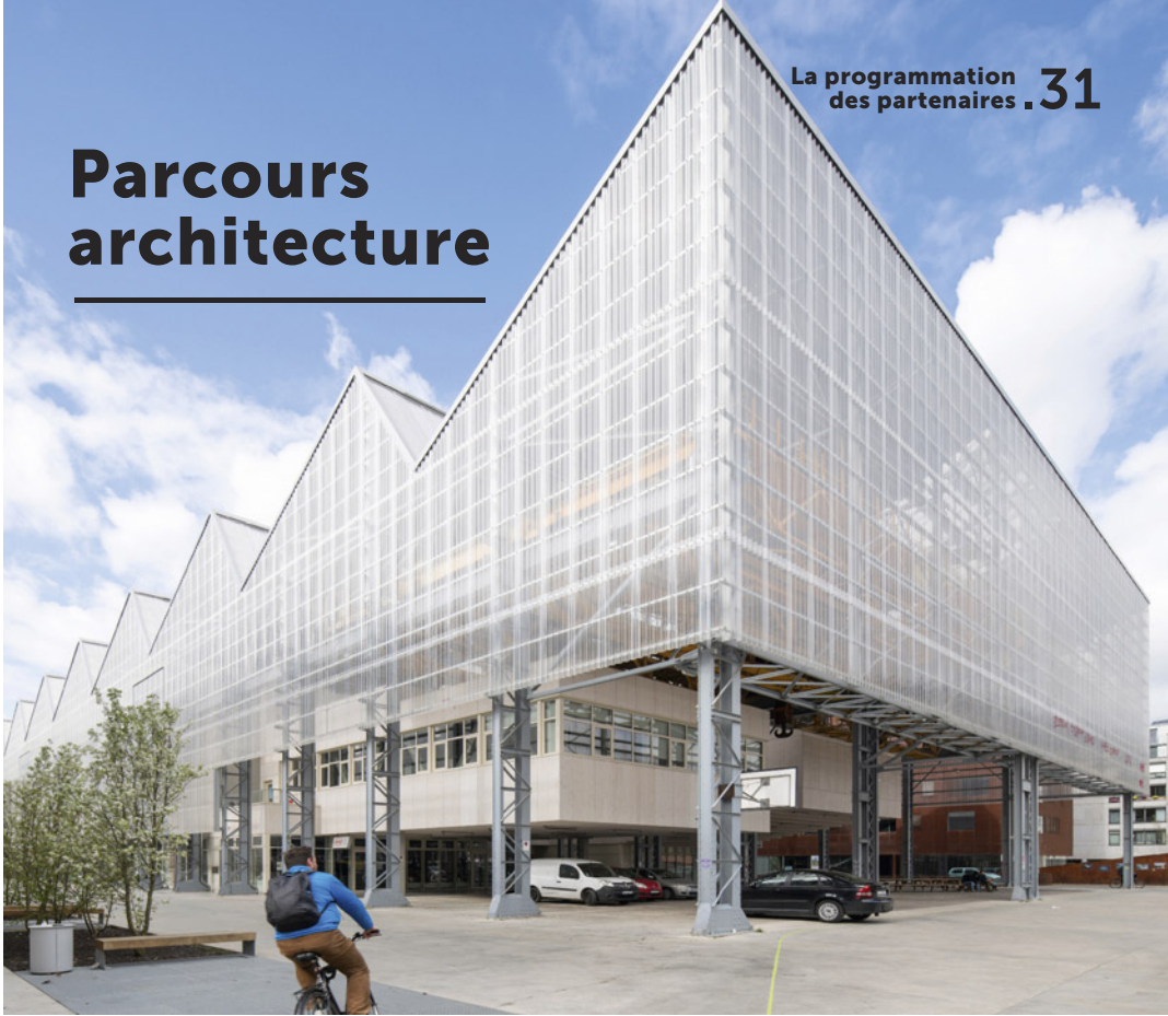
École des Beaux-Arts de Nantes Saint-Nazaire, architecte Franklin Azzi © Martin Argyroglo / LVAN
